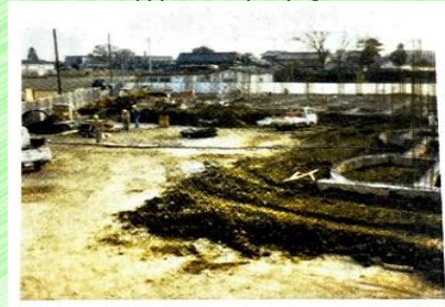
特養はなぶさ苑工事
